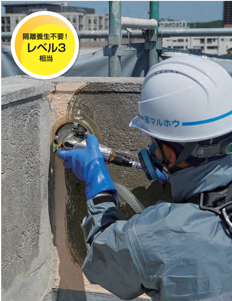
露筋・欠損部
